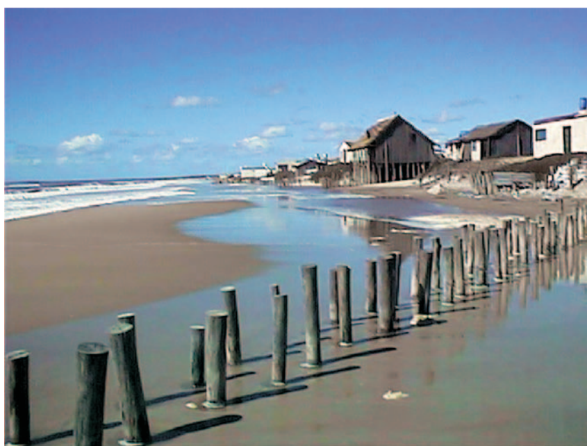
Figura 16.8 Erosão costeira na Praia do Hermenegildo (RS), provocada principalmente por construções sobre as dunas costeiras. [Foto: ASMUS, M.L.].
